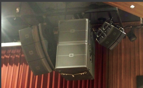
▲R側のメインスピーカー。「VRX932LA-1」と「VRX918S」に加えて、一回り小さい「VRX928LA」がフライングされている。
