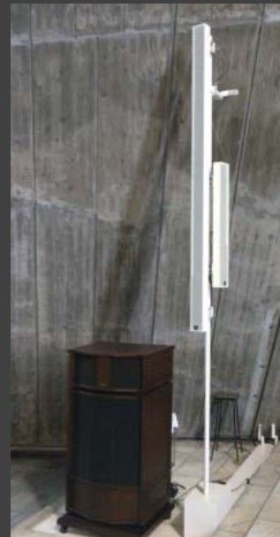
▲会衆席用の「Ivx-DSX280」と祭壇用の「Ivx-DS115」が同じスタンドに取り付けられている。
