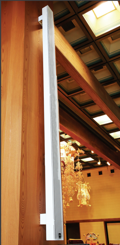
▲ 付属金具で柱に設置された「Ivx-DSX280」。
