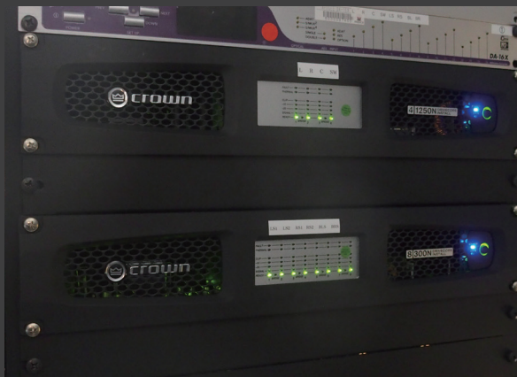
▲パワーアンプはフロント・スピーカー／サブウーファー用に「DCi 4|1250N」、サラウンド・スピーカー用に「DCi 8|3000N」を導入
