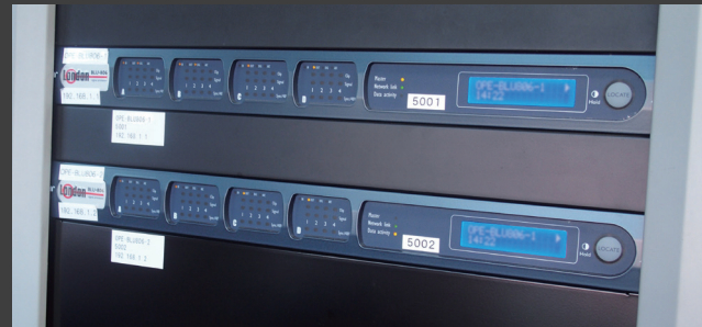
AES/EBU から Dante に変換し、アンプルームに▶ 送る信号を制御する [BLU-806]。
