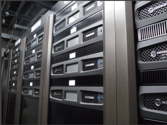
◀アンプ室にラックマウントされた CROWN(AMCRON) [DCi 4|600N] と [DCi 4|300N]
