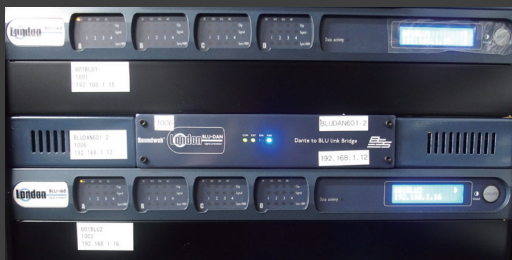
▲Dante から BLU link に変換する [BLU-DA] とスピーカー への信号を制御する [BLU-160]
