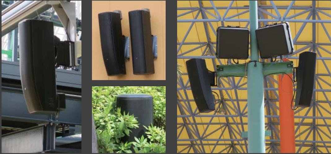
▲メインゲートやアトラクションの入口に設置されている CBT Series。低域用スピーカーの「CBT 70JE-1」は植え込みの中にも配置されている。
