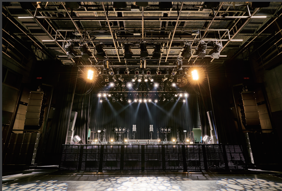
▲ ホールの左右に CODA AUDIO のラインアレイシステムが吊られている。
