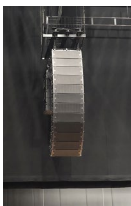
メイン・スピーカーとして導入された VTX A Series。 サイド (LR) スピーカーは VTX-A12 が 12/3 対抗という構成
